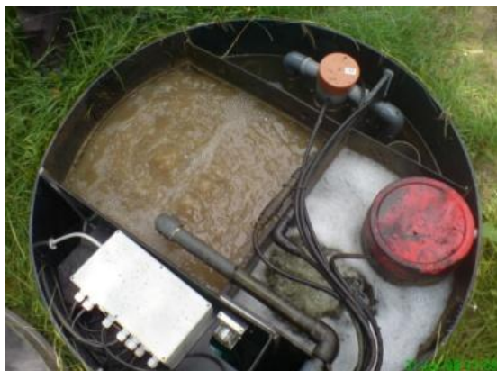
Figur 1: Overbelastet anlæg med slamflugt (vandet er brunt) pga. flydende vaskemiddel (det hvide skum er fra vaskemidlerne).
