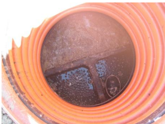
Figur 4: En optimal bundfældningstank (der er tyk mørk slam i kammer 1, og næsten ingen slam i kammer 2 og 3)
