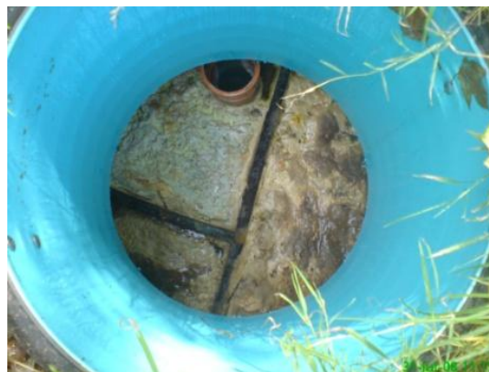
Figur 5: En dårlig og ikke optimal bundfældningstank (slammet er lyst, tynd i konsistens og der er slam i alle kamre)
