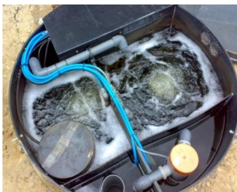
Figur 3: Et lavt belastet renselanlæg. (Vandet er klart, og der er kun ganske lidt skum og ingen lugt).
