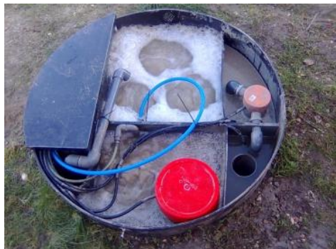
Figur 2: Et meget belastet renselanlæg med rengøringsprodukter (vandet er hvidt, det skummer meget og det lugter af svovlbrinte)
