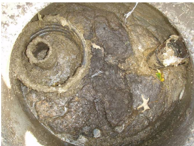
Tank med indsats nedsivning er stoppet!
