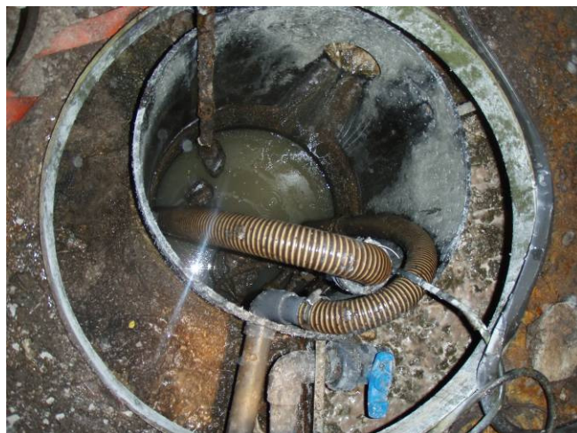
Nyere tank m. pumpebrønd, svær at tømme
