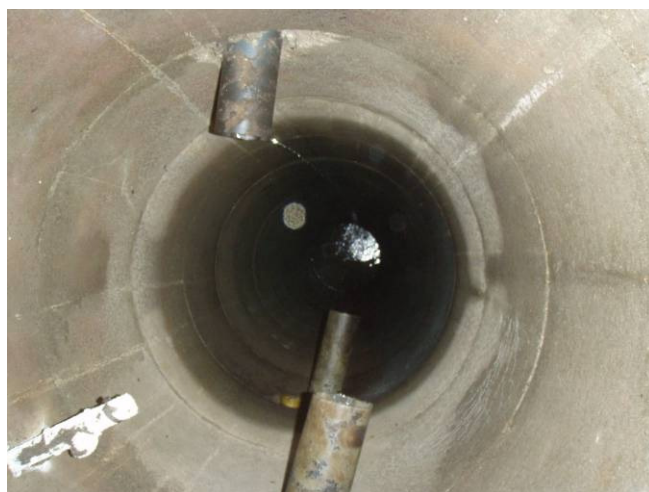
Gl. drikkevands brønd bruges som sivebrønd!
