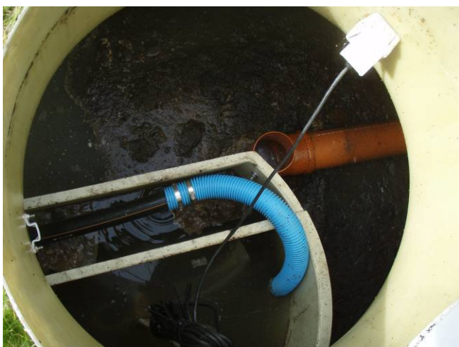
Nyere tank m. pumpebrønd som er svær at tømme
