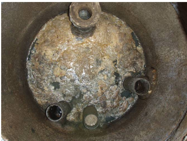
Gl. septiktank m. 3 tilslutninger
