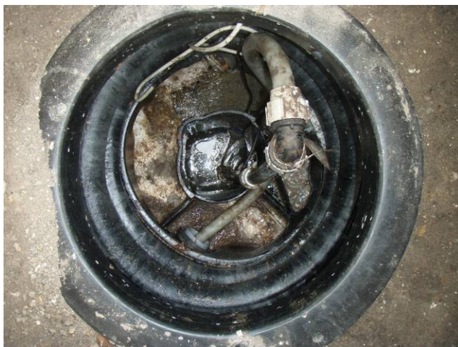
Nyere tank med pumpebrønd, svær at tømme
