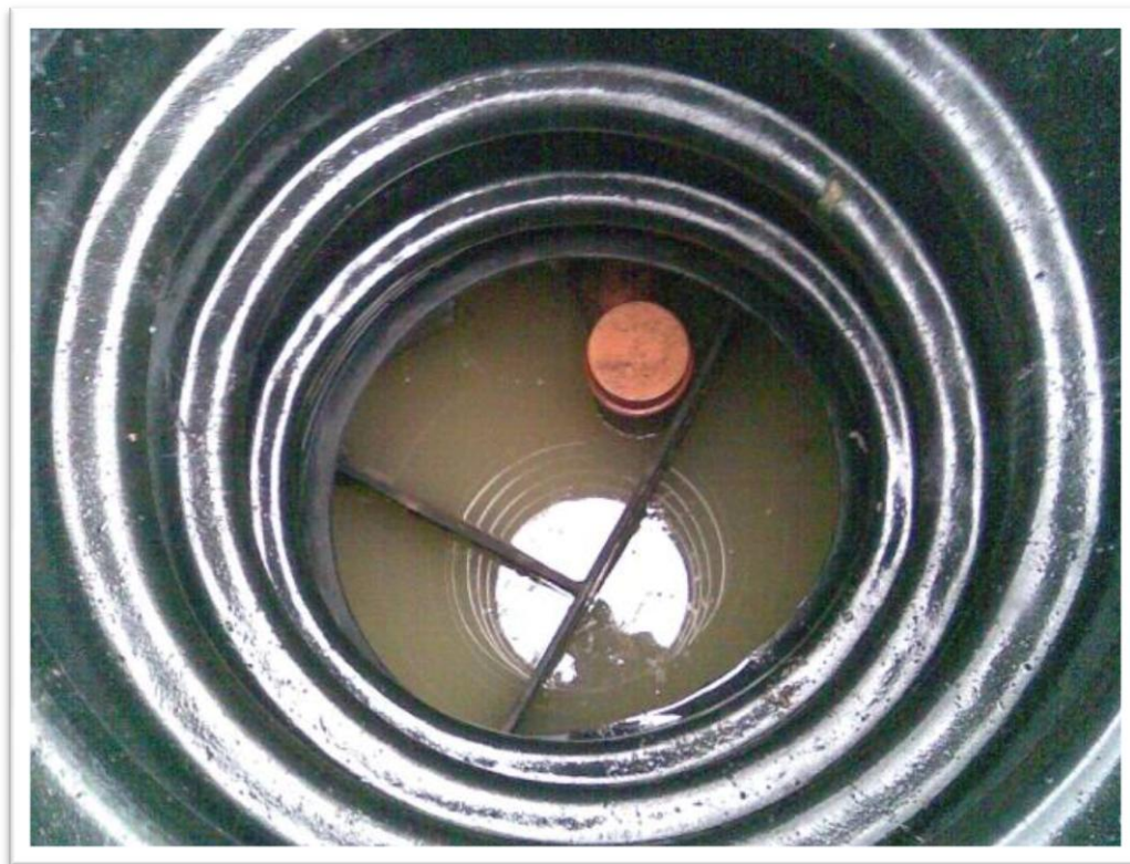
Billede 6: Bundfældningstank kort efter tømning
