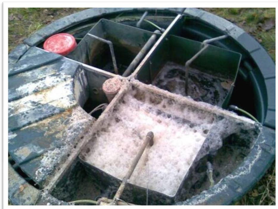
Billede 8: Skumdannelse efter tømning af bundfældningstank med afvandingsbil 4
