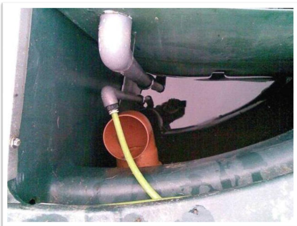
Billede 7: Lavt vandniveau i sidste rensekammer efter tømning af bundfældningstanken
