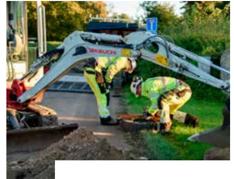
Gang i arbejdet med at sikre grundvandet og dermed det rene drikkevand på Orø i Isefjorden.
