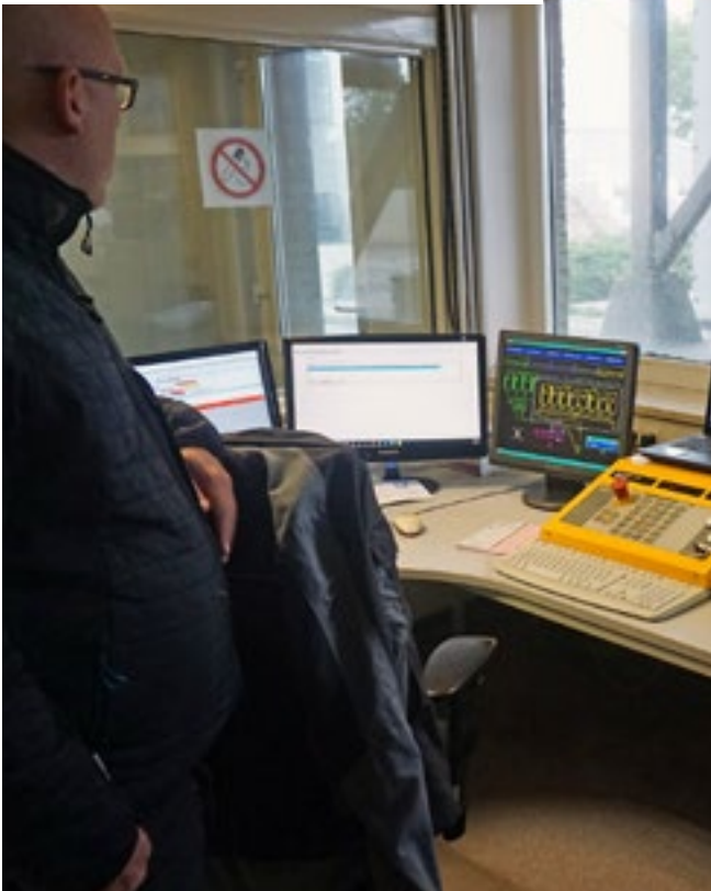
Pillefingre skal holde sig væk fra kontrolpanelet. Her overvåges den perfekte betonblanding til en WS Bioclean-betonbeholder.
