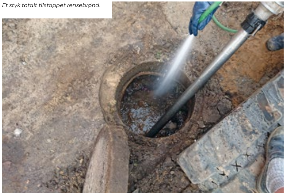
Et styk totalt tilstoppet rensebrønd.
