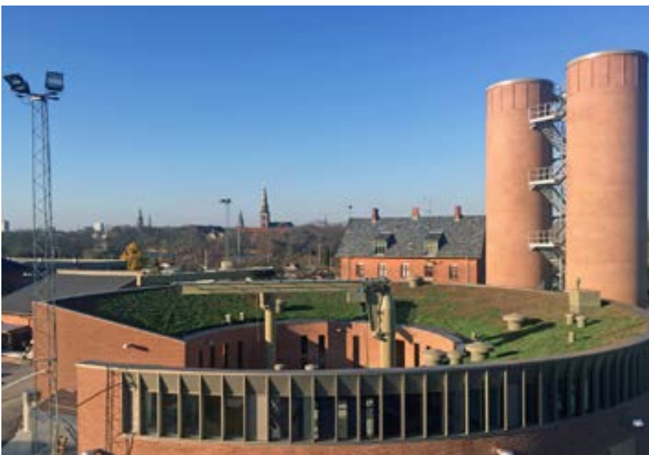
De to tryktårne er ganske iøjnefaldende. De er 28 meter høje, hvoraf de 24 meter er over terræn.
