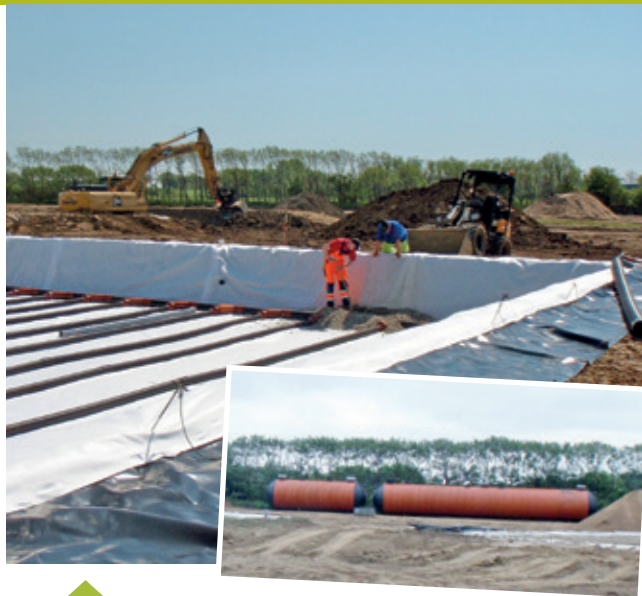
Gravemaskinen har taget hul på at fylde sand i et af bassinerne. Omkring 6000 tons grus er sejlet til Strynø til etablering af øens nye rensningsanlæg.
