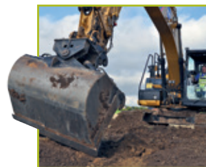
▲ Regnvandsbassiner og vandløb med 3D-styring
