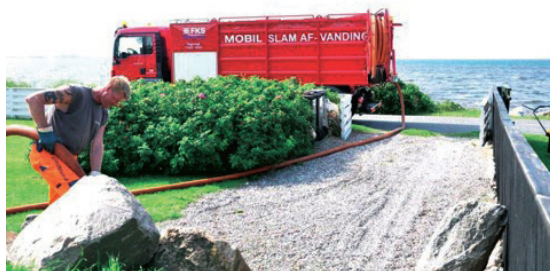
Enhver ændring af en septiktank medfører, at en kloakmester skal udføre et stykke arbejde, derfor er tømningsordninger værdifuld information for kloakmesteren.
