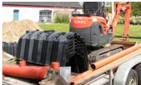
De enkelte tunnelmoduler stables oven på hinanden og fylder derfor ikke meget på traileren.
