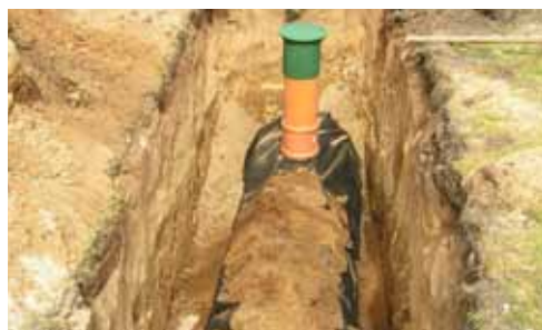
Til slut kan monteres et overløb, således at overskydende vand ved ekstreme regnskyl kan ledes ud.
