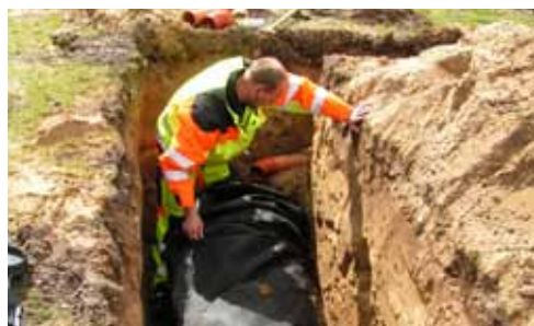
Tunnelmodulerne placeres oven på geotekstil i udgravningen og pakkes ind for at forhindre jord og sand i at trænge ind og stoppe tunnelen.
